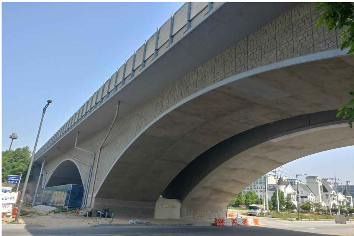
거더, 바닥판하면 전경
