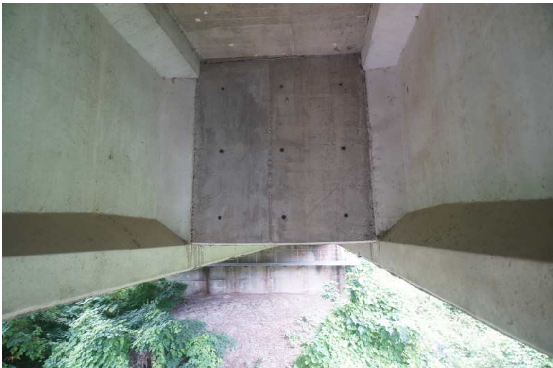
거더 및 가로보, 바닥판하면 전경
