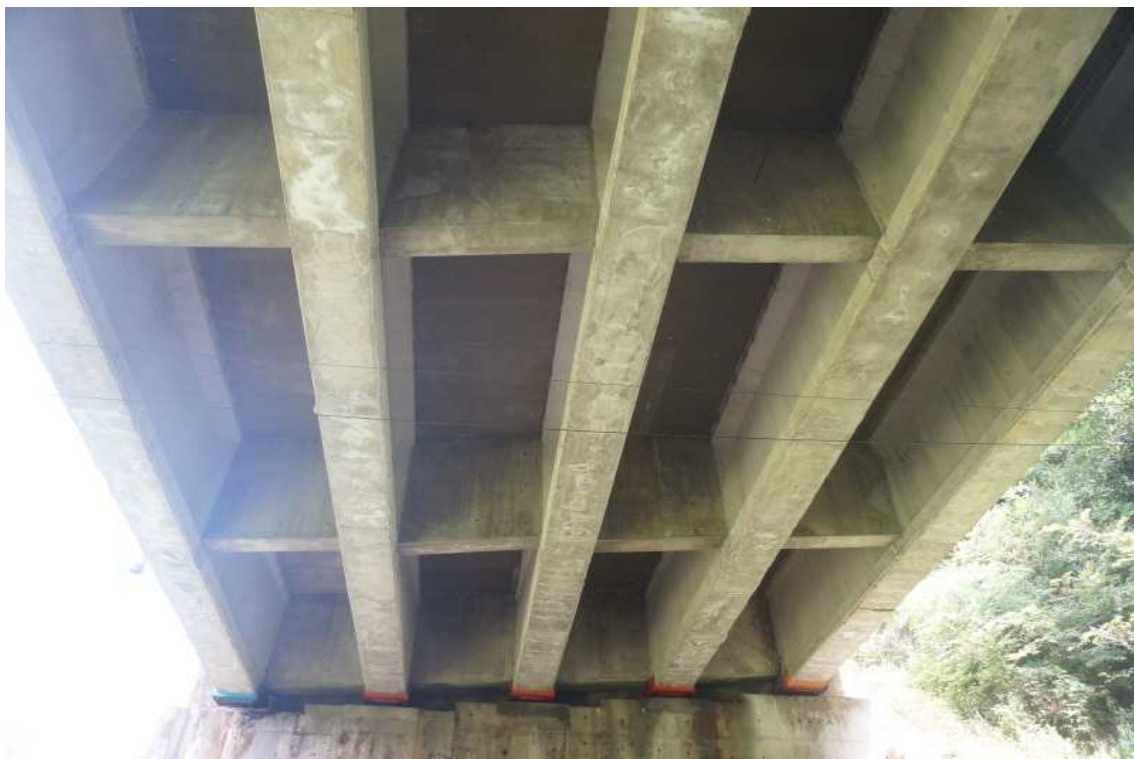
거더 및 가로보, 바닥판하면 전경
