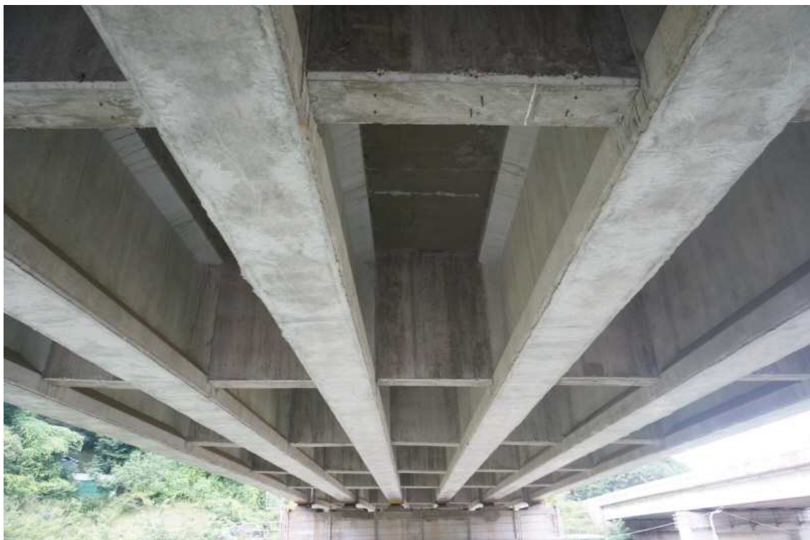
거더 및 가로보, 바닥판하면 전경
