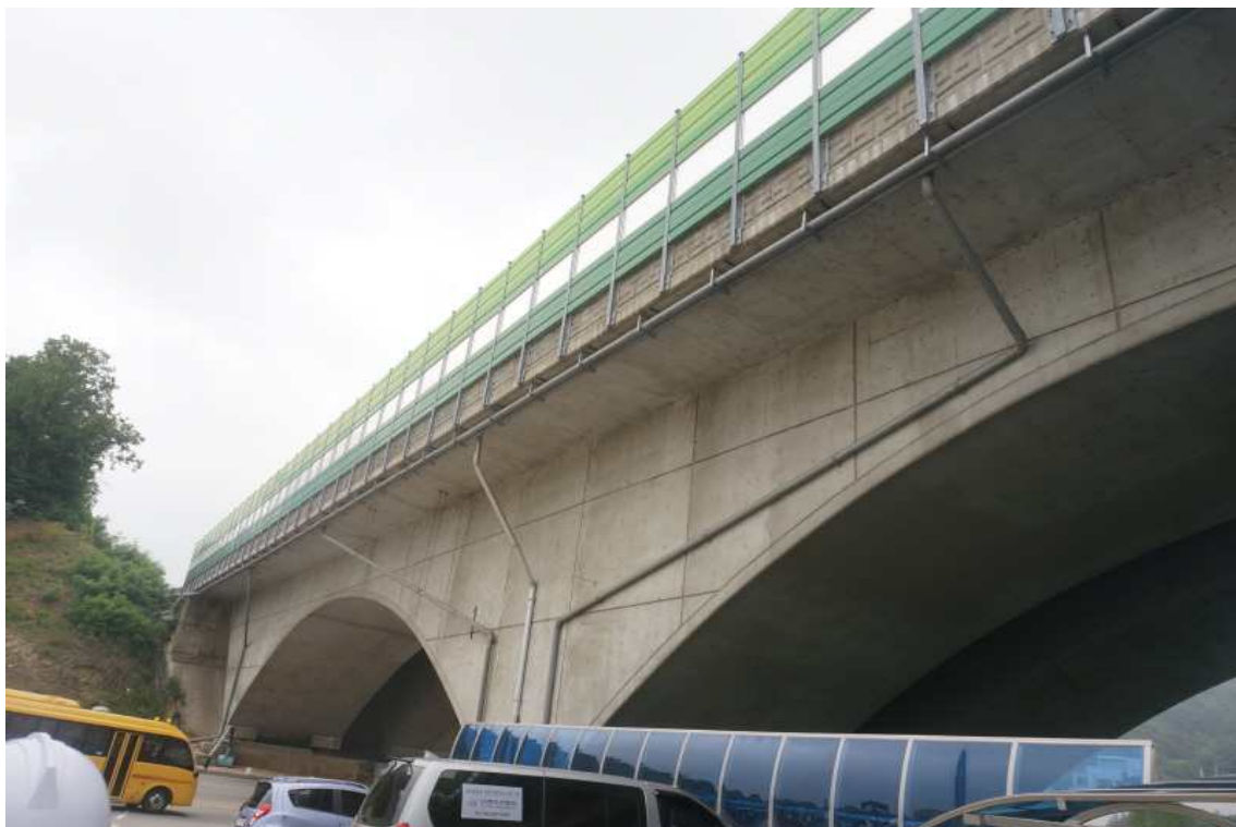
거더, 바닥판하면 전경
