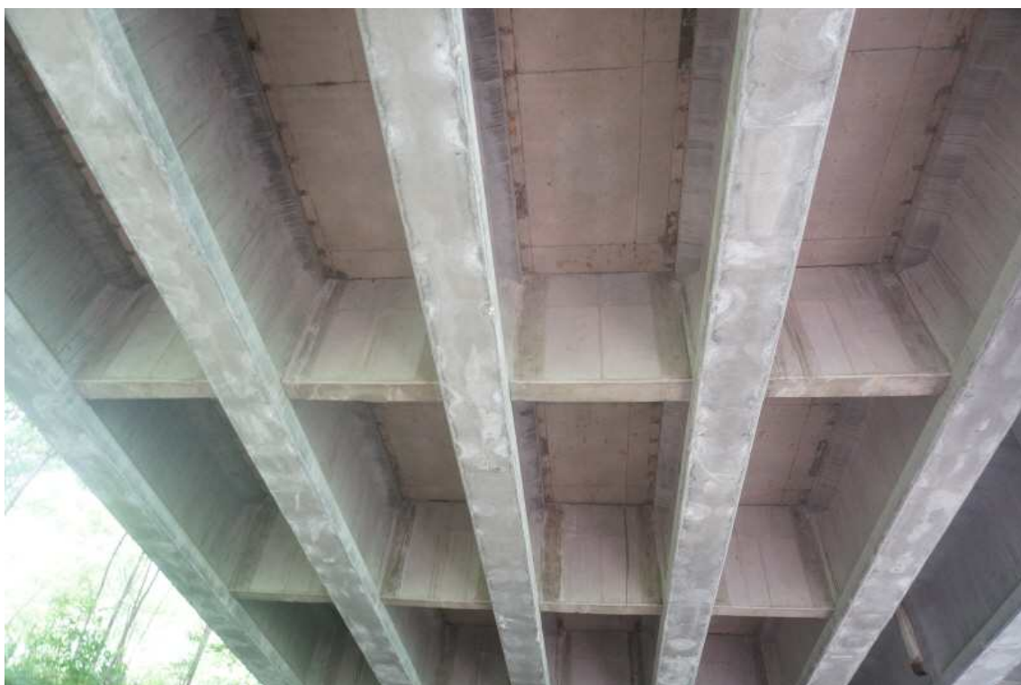
거더 및 가로보, 바닥판하면 전경
