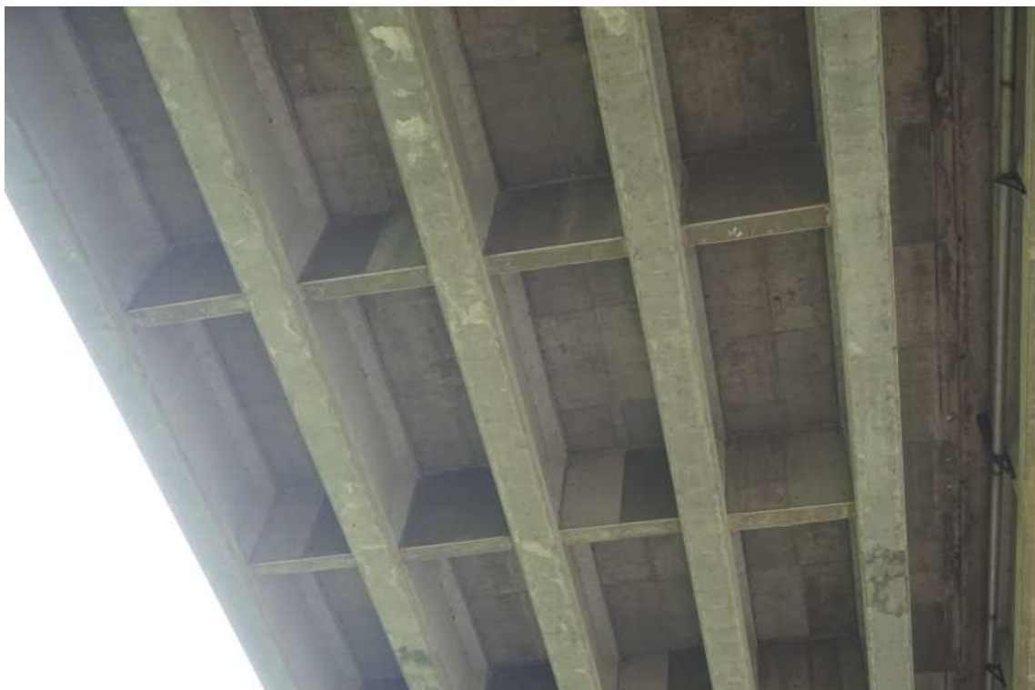
거더 및 가로보, 바닥판하면 전경
