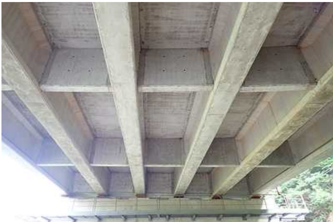
거더 및 가로보, 바닥판하면 전경
