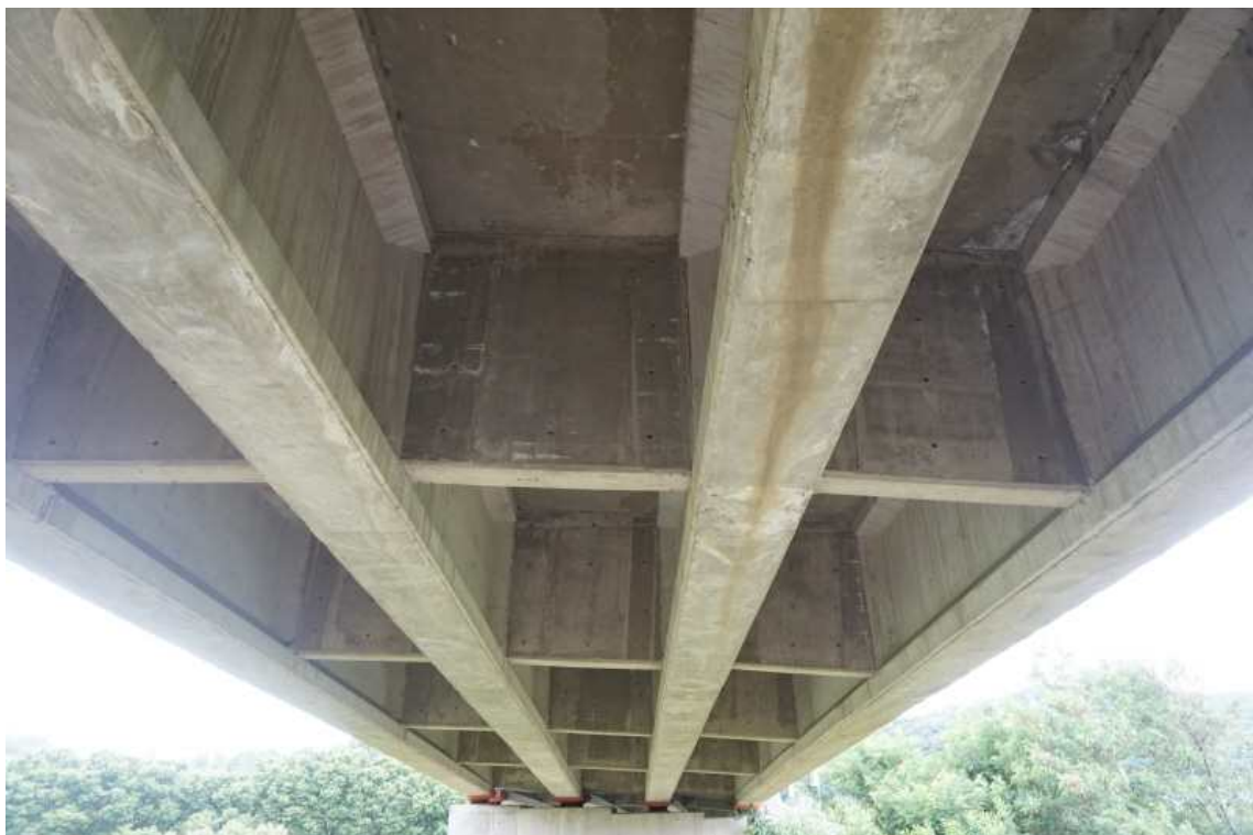
거더 및 가로보, 바닥판하면 전경
