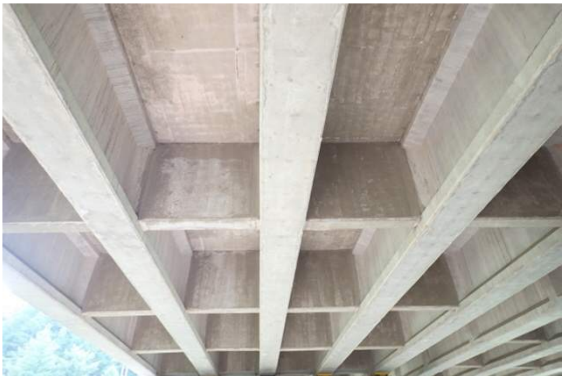
거더 및 가로보, 바닥판하면 전경
