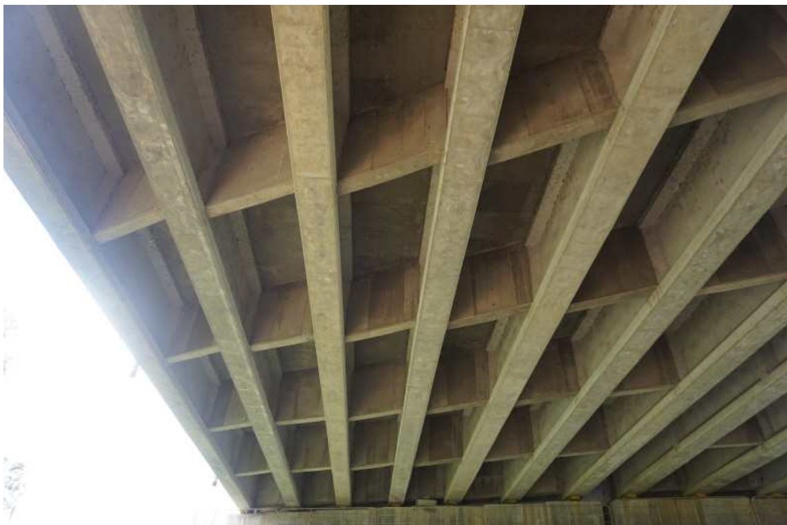
거더 및 가로보, 바닥판하면 전경
