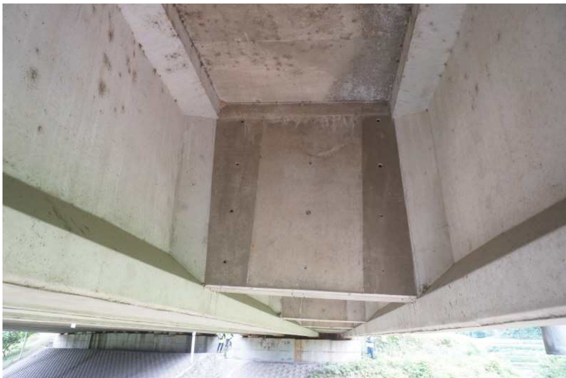
거더 및 가로보, 바닥판하면 전경
