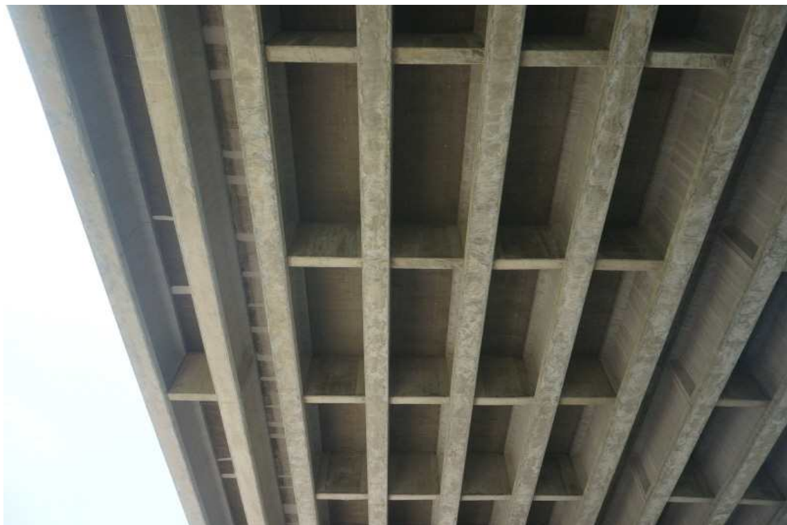
거더 및 가로보, 바닥판하면 전경
