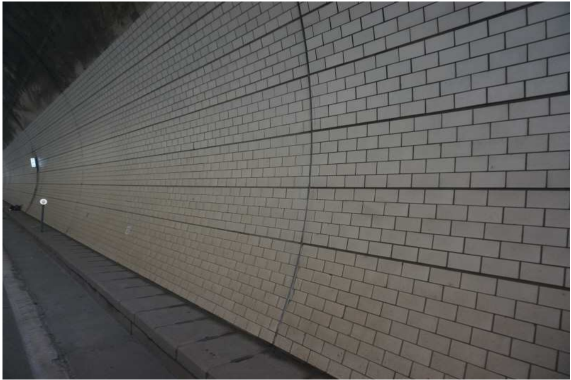
공동구 및 측벽 전경
