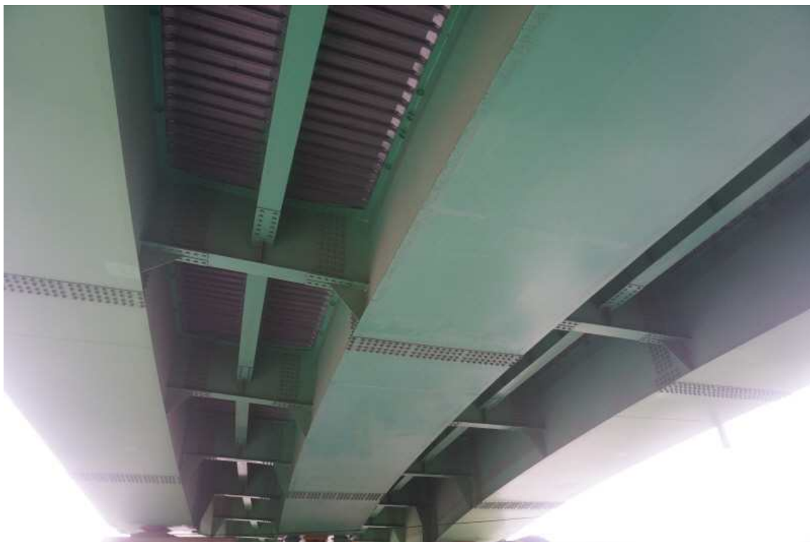
거더 및 가로보, 바닥판하면 전경
