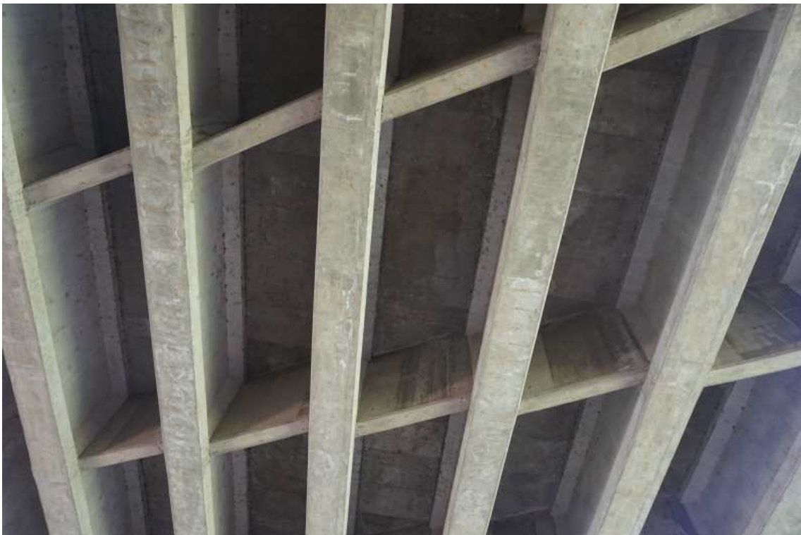
거더 및 가로보, 바닥판하면 전경
