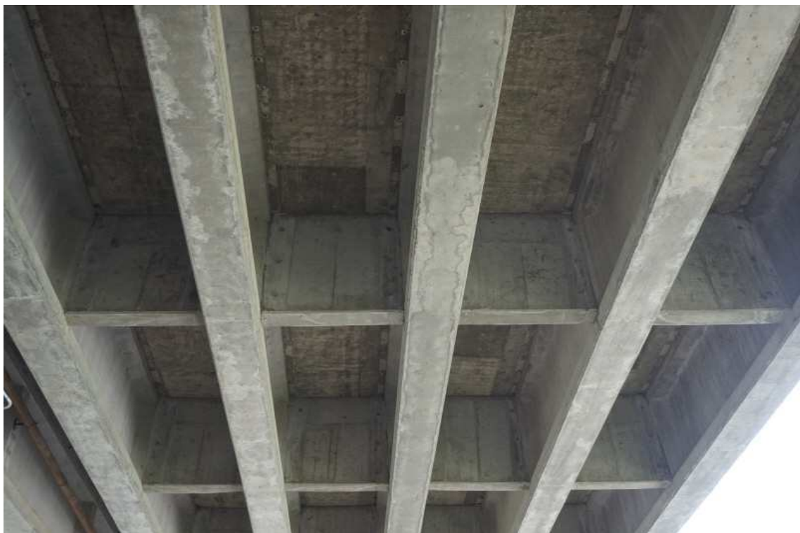
거더 및 가로보, 바닥판하면 전경
