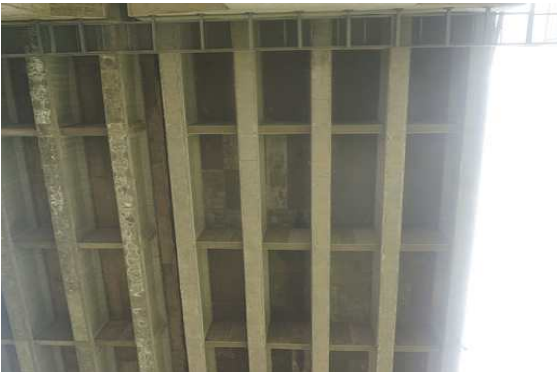
거더 및 가로보, 바닥판하면 전경
